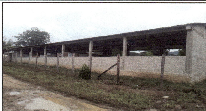
Foto 2: Detrás de las aulas, es más fácil que entre agua en tiempo de invierno, con la instalación de ventanas de balcones con vidrios brinda mayor seguridad a las pertenencias de los alumnos.
